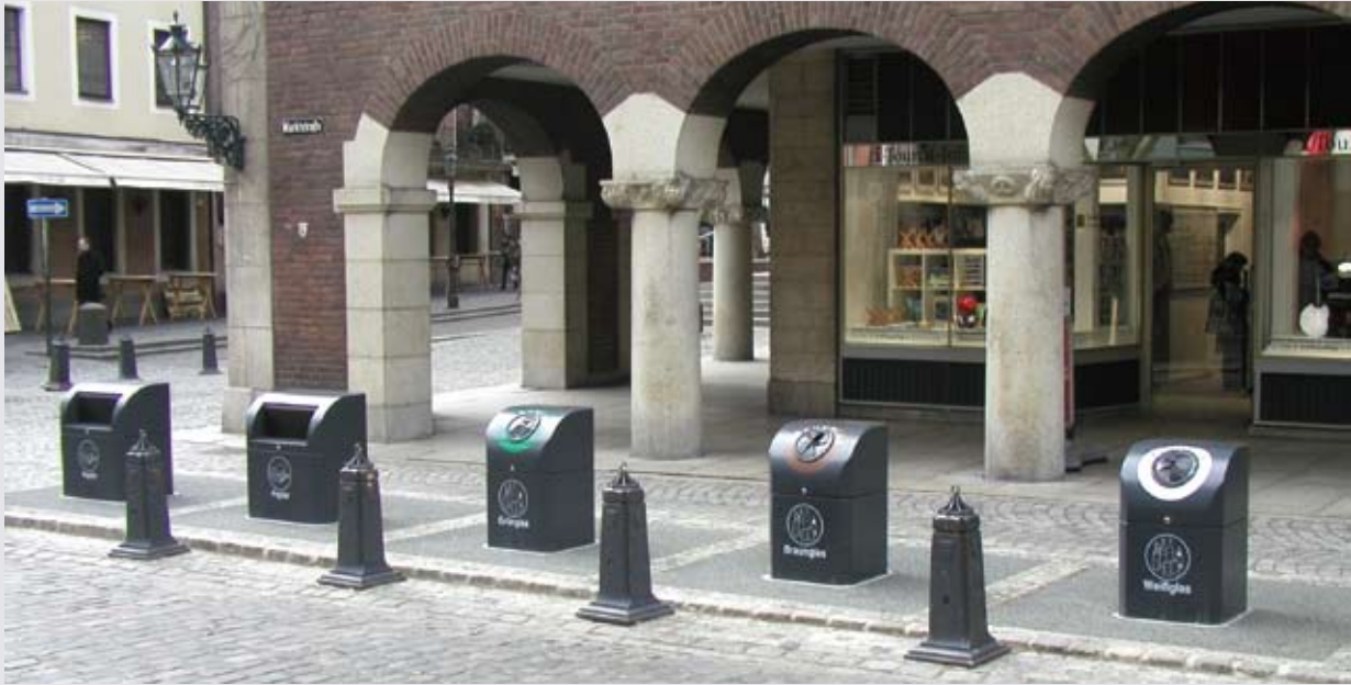
Unterfluranlage Europa in der Düsseldorfer Altstadt
